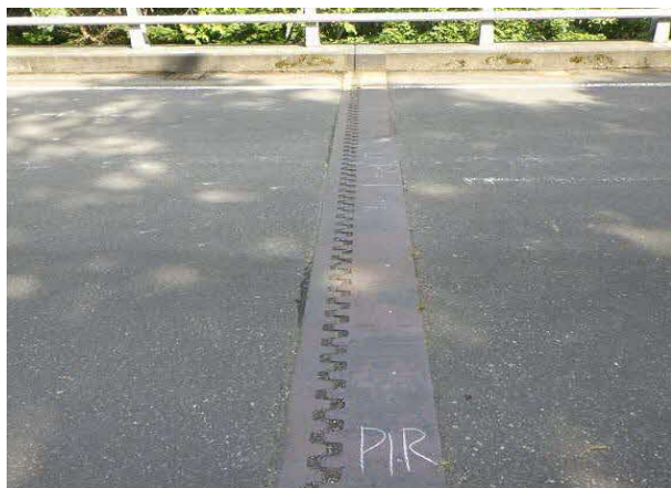
伸縮装置取替え(フィンガージョイント)
