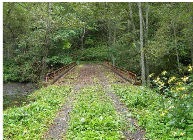
歌越別橋【全景】 昭和38年架設 荷重制限1.5t
