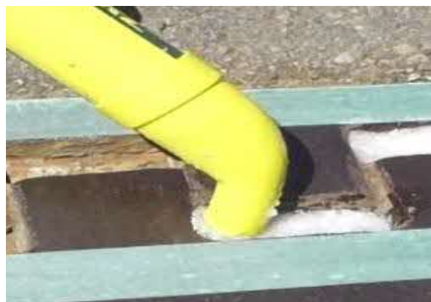
耐圧防水樹脂充填による防水補修工法
