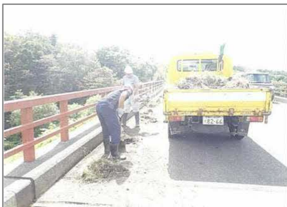
明里百年橋 土砂積込・撤去
