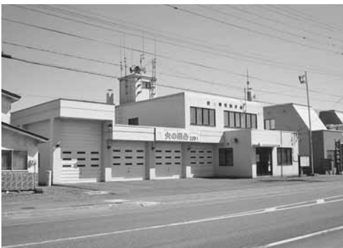
30年度、耐震改修工事を行う予定の消防庁舎
